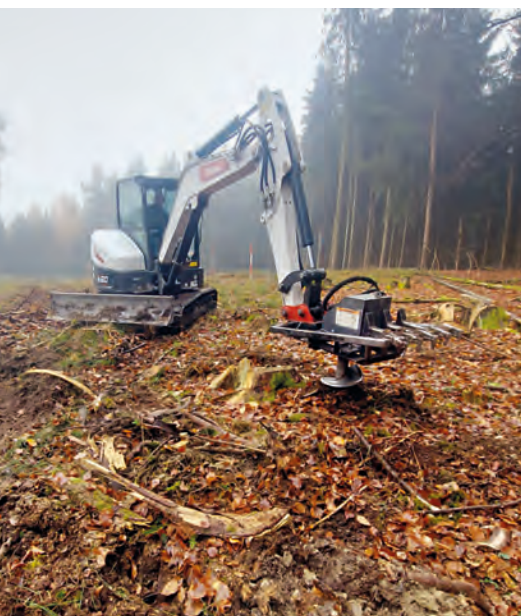
Das Pflanzloch wird gesetzt...
