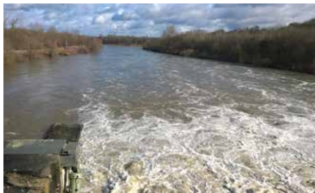
Foto 1: Die Isar unterhalb der Stützkraftstufe Landau am 4. Februar 2020. Pro Sekunde können maximal 195.000 Liter durch die Turbinen des Kraftwerks auf der linken Flussseite fließen. Ein Mehrfaches davon schwappte wild schäumend zusätzlich rechts über die Hochwasserableitung des Wehrs ins sogenannte Tosebecken. Genügend Wasser, dass sich die Isar rund 1 km flussabwärts vorzeitig den Weg zu ihrem neuen Bett bahnen konnte. (Foto: Hobmaier)
